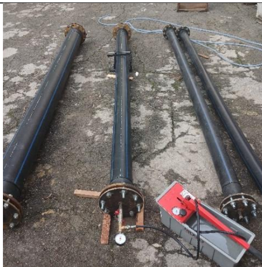
Foto 10. Restabilirea formei tubului cu pompa hidraulică
